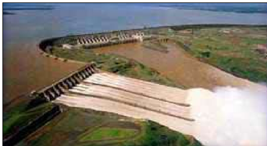
Figura C.03- Vista aérea da usina (ITAIPU BINACIONAL, 2002).
